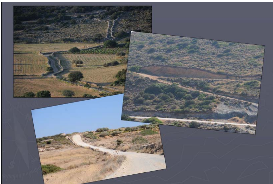
Εικ. 8, διάνοιξη νέων οδών – καταστροφή τοπίου και συνέχειας υπαίθρου
